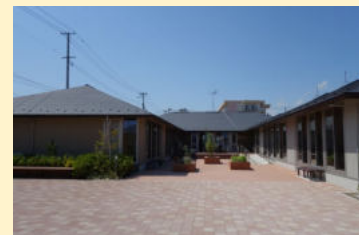
東日本大震災被災地で実現した 共助型災害公営住宅
